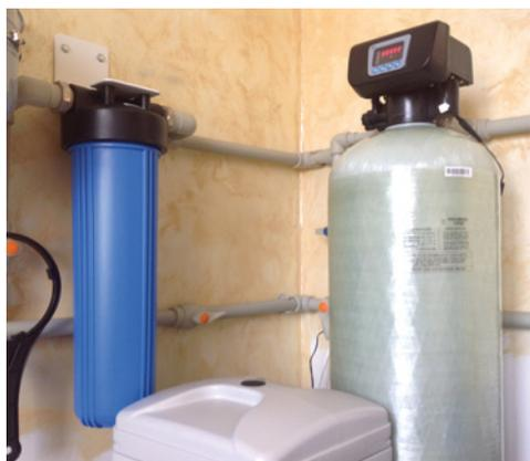
Рис. 1. Установка для умягчения воды в системе автономного водоснабжения
