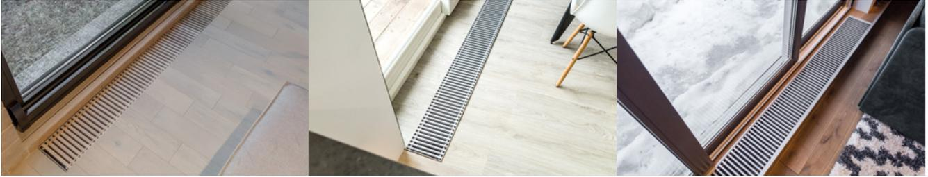
*Высота конвекторов «Бриз» выбирается из ряда 80-120 мм, для «Бриз В» – 85 и 120 мм. Длина приборов может составлять до 5000 мм или быть сборной под единую решетку до 25 метров. Рабочее давление – 15 атм, испытательное – 25 атм. Температура теплоносителя – до 120°C. Гарантия на всю продукцию KZTO – 5 лет.*
