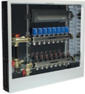
Теплые полы – одним из популярных современных решений для отопления помещений. Возможность регулирования температуры в каждой комнате для систем отопления с теплыми полами решает коллектор, который обеспечивает отдельную регулировку каждого контура водяного пола.
